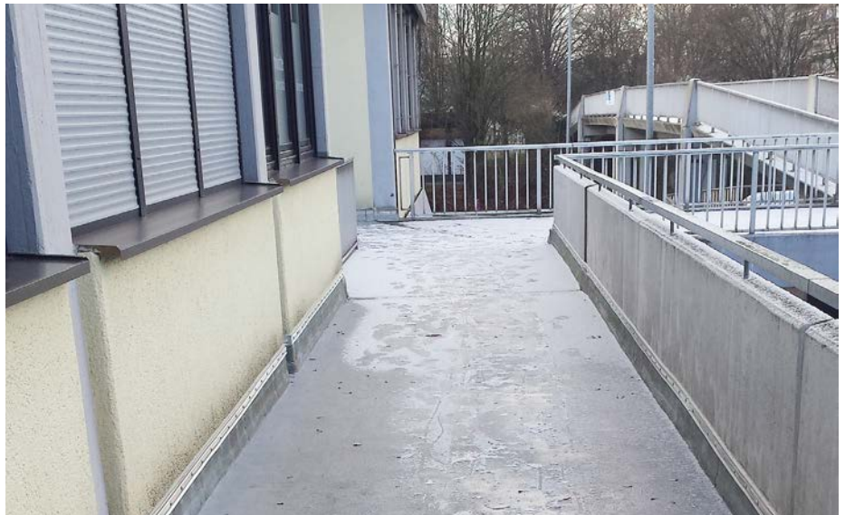
Galt 1970 als modern: Beton-Stege, die Gebäude verbinden und Straßen überqueren.
