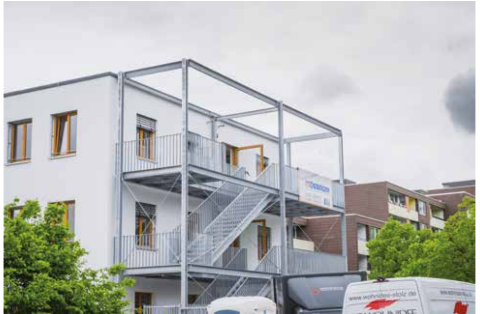
Neustes Palm-Projekt: die Holz-Klinik in Pforzheim mit Fluchttreppen, die als Balkon dienen. Diese sind wichtig für die dort lebenden Intensivpflege-Bewohner.
